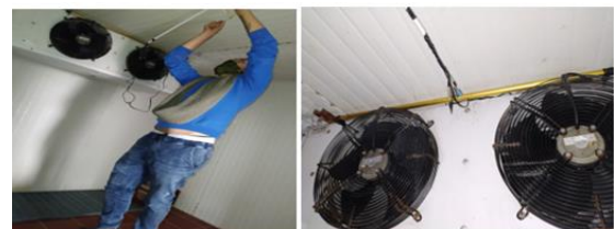
Figura 16 Instalación de sistema de monitoreo y control (Investigacion2020)
