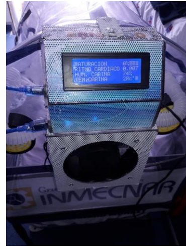
Figura 7 Sistema de ventilación y filtrado y sistema de automatización instalado en cabina de aislamiento. (investigación, 2020)
