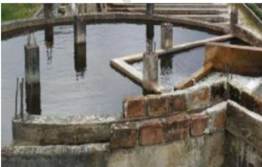
*Figura 4 Tanque de almacenamiento y filtrado de agua Acuímayo*
