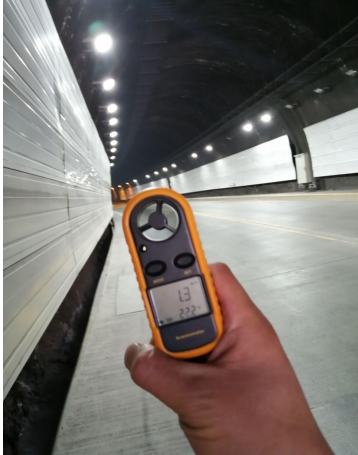
Día de campo en Túnel de Daza. Fuente, propia
