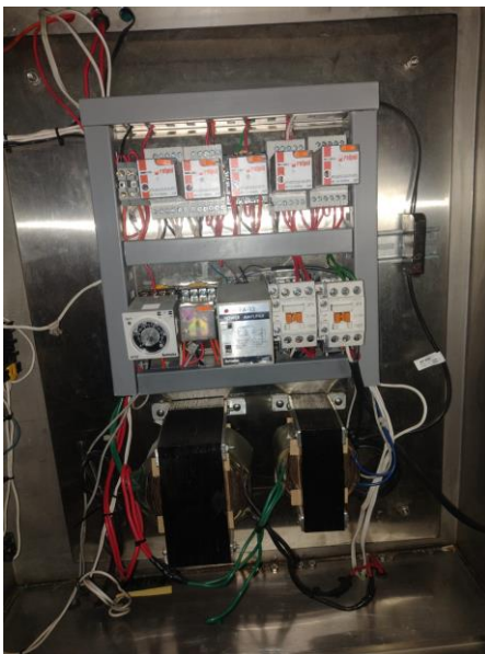
figura 13.sistema de control y electricidad. fuente ( esta investigación 2022).
