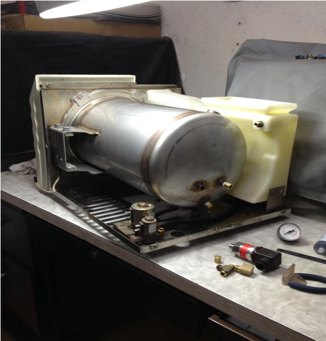
Figura 73 Instalación de los racores de \frac{1}{4} para luego adecuar el sensor de presión danfoss
