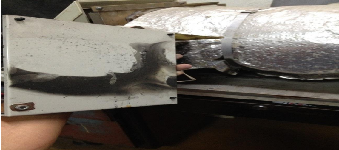
Figura 65 Desmontaje de los elementos que la componían
