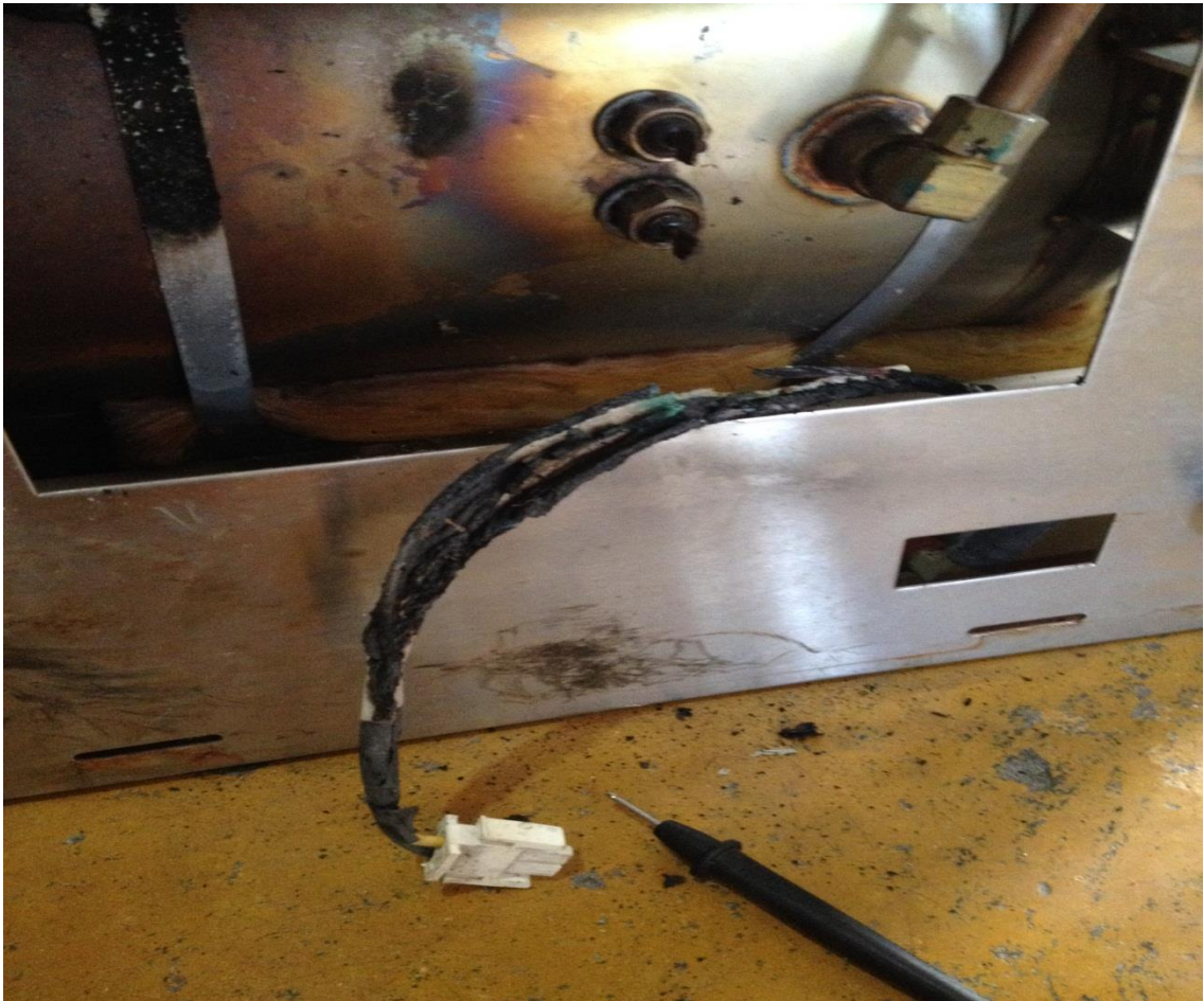
Figura 64 Daño en la conexión de las resistencias eléctricas
