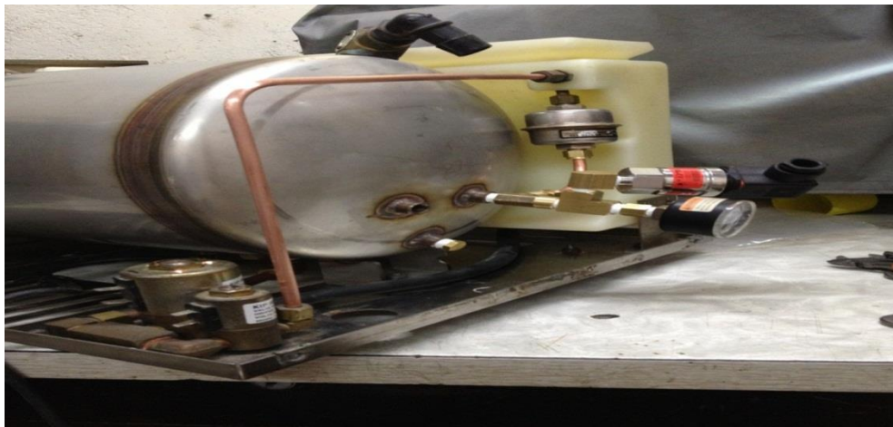
Figura 77 Instalación tubería de cobre
