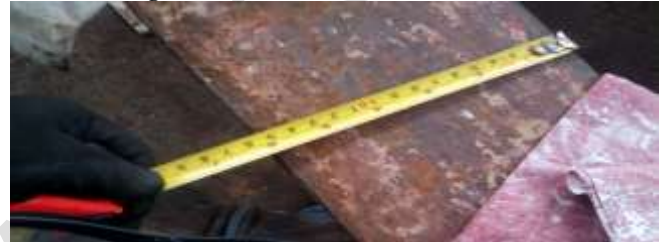
Figura 15. Ancho de base de la estructura.
